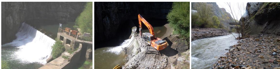
Ilustración 1. Azud de la Gotera (CH Duero, León) antes, durante y después de su demolición respectivamente.
