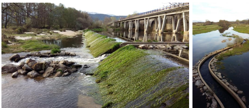
Ilustración 1. Escala para peces en el río Tiétar, que salva el azud de protección de las pilas del viaducto de la carretera N-502 en el límite entre Ávila y Toledo. Se trata de una rampa naturalizada que discurre entre los sedimentos depositados por el remanso que produce dicho azud. La ubicación «atípica», aguas arriba del muro del azud, permite conservar la función de éste de evitar la erosión de los pilares del viaducto. Su desarrollo sinuoso y su recubrimiento exterior con escollera, la integran en el entorno.
