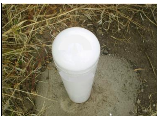
Mojón de señalización de línea de DPH en campo
